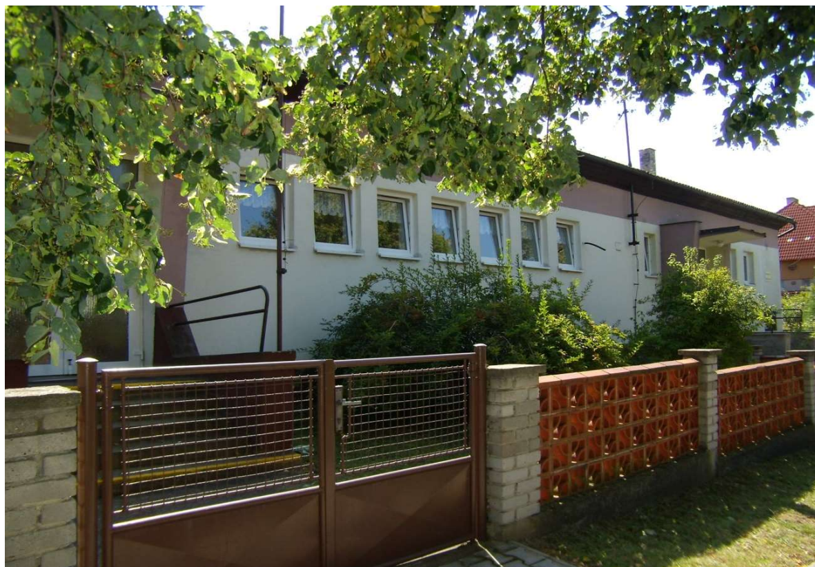
Budova před rekonstrukcí:
